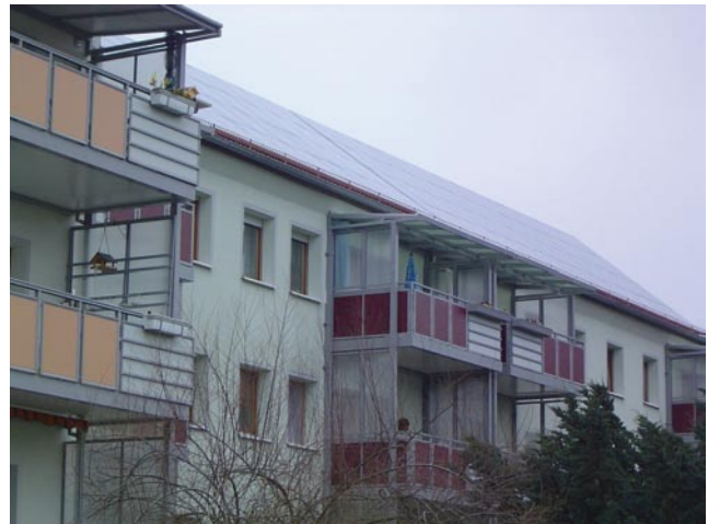
Abb. 3 Photovoltaik-Module der Allg. Wohnungsbaugenossenschaft Eisenach eG in der Friedrich-Liszt-Straße
